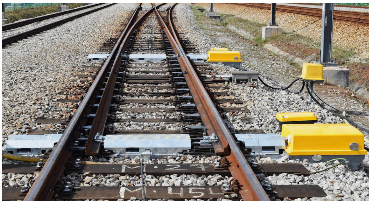
Ovládání výhybky pomocí dvou přestavníků řady EP-6xx
