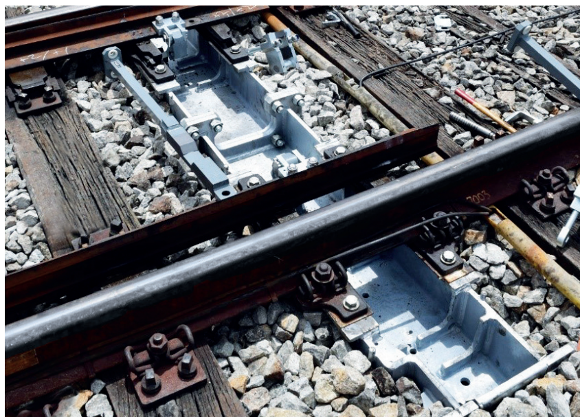
Wariant wąski ZP-01 – dwuczęściowy wariant po regeneracji rozjazdu
