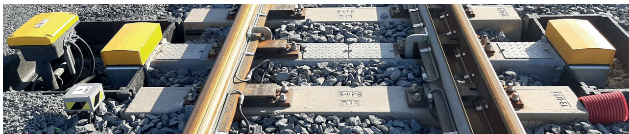
Umocowanie KPI-41 na rozjeździe
