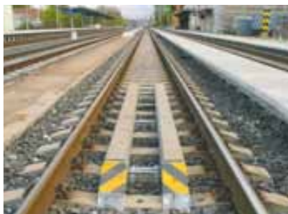
Informační bod v kolejišti
